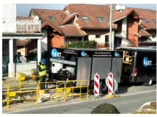
Application de la résine : sur une distance jusqu'à 180 m de linéaire par jour, la technique permet une remise en service le jour même, car la résine est sèche au toucher après seulement quelques secondes.
